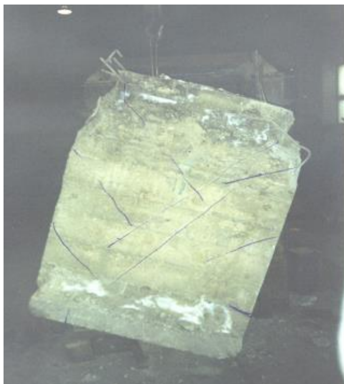
Рисунок 2.7 – Однослойный фрагмент стены после испытаний
