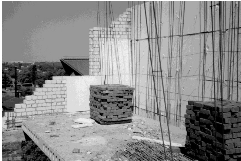
Рисунок 1.7 – Наружная стена 12-этажного жилого здания в г. Краснодаре
