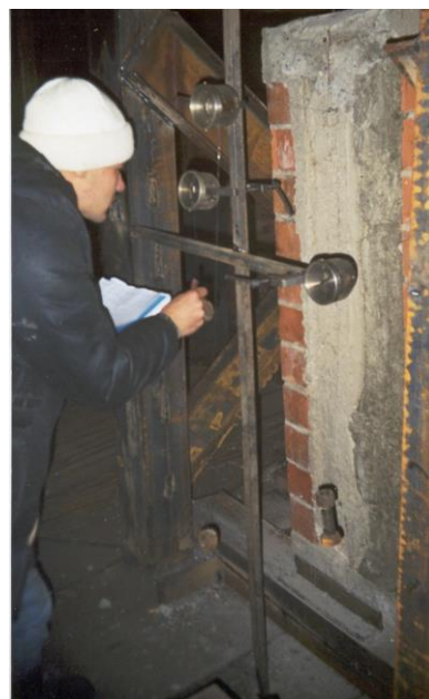
Рисунок 2.6 – Установка прогибомеров при испытании многослойных фрагментов
