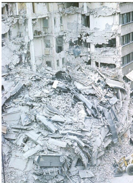
Рисунок В.1 – Разрушение многоэтажного жилого дома с несущими стенами из кирпичной кладки в результате Румынского землетрясения 1977 г. [167]
