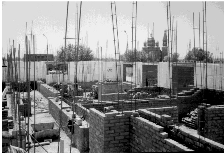
Рисунок 1.8 – Возведение 9–14-этажного дома в г. Краснодаре
