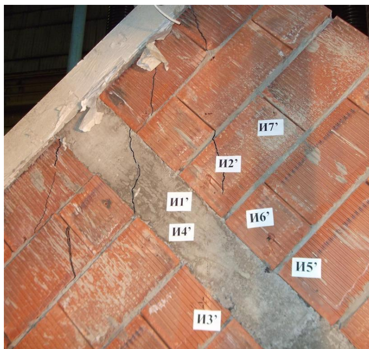
Рисунок 2.54 – Раскрытие трещин в образце ВК–2. N_p = 280 кН
