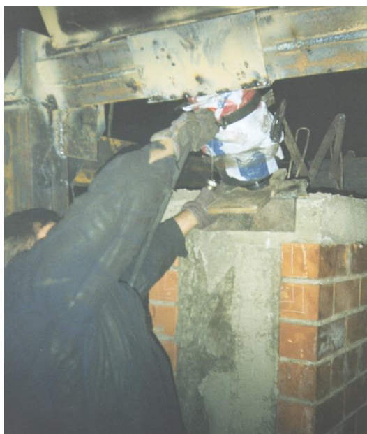
Рисунок 2.1 – Установка домкрата в рабочее положение
