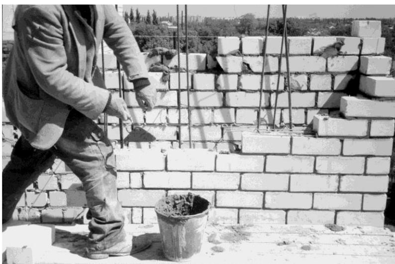
Рисунок 1.9 – Фрагмент многослойной стены 12-этажного дома в г. Краснодаре
