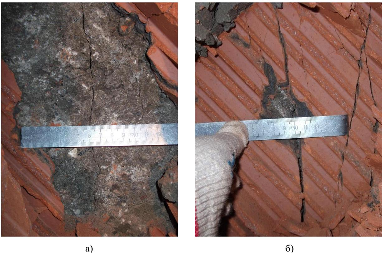
Рисунок 2.36 – Диагональная трещина внутреннего железобетонного слоя:
