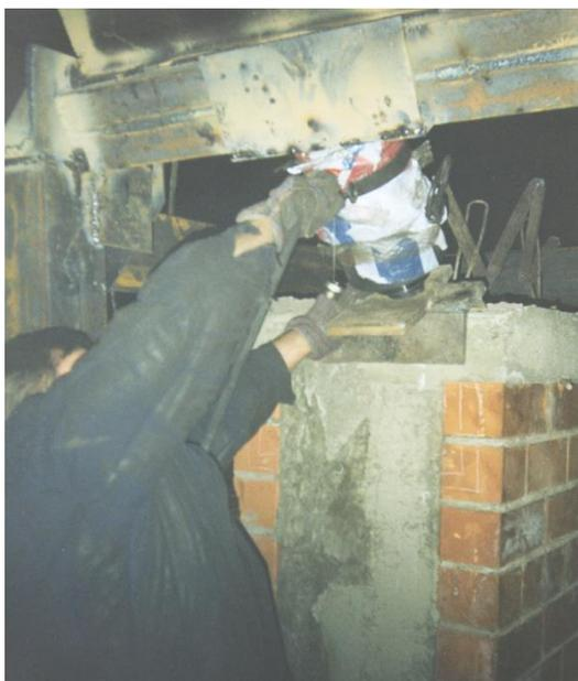
Рисунок 2.1 – Установка домкрата в рабочее положение
