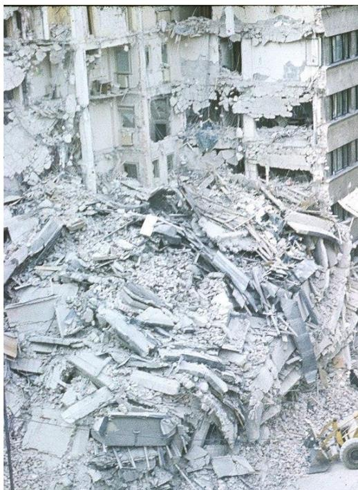
Рисунок В.1 – Разрушение многоэтажного жилого дома с несущими стенами из кирпичной кладки в результате Румынского землетрясения 1977 г. [190].
